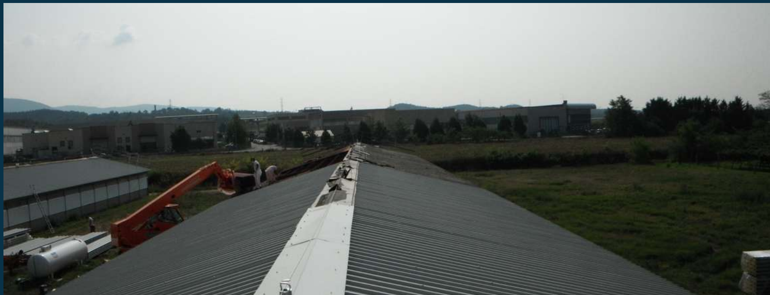
Fase di rimozione amianto - installazione impianto fv
