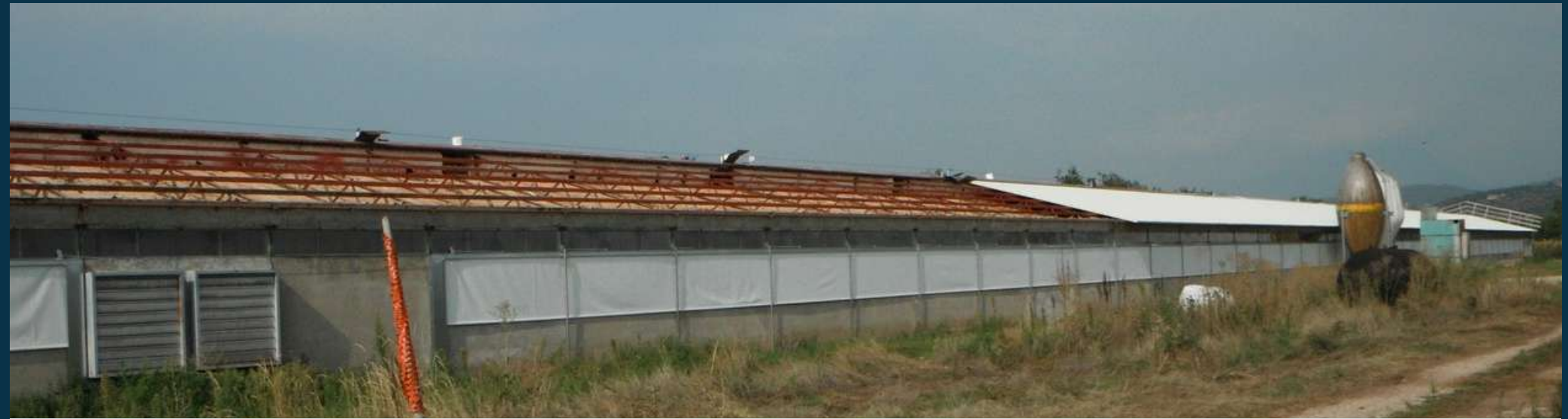
Fase di rimozione amianto - installazione impianto fv
